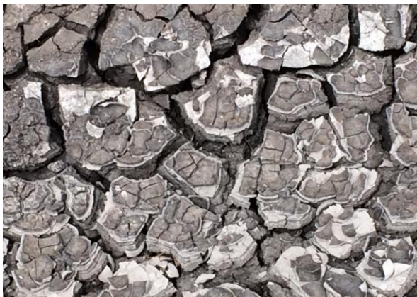
FOTOGRAFÍA 10.- GRIETAS DE TENSION SUPERFICIALES. EN EL EX LAGO DE TEXCOCO SE HAN REPORTADO GRIETAS DE TENSION DE CIENTOS DE METROS DE LONGITUD, CUYAS PROFUNDIDADES ALCANZAN LAS DECENAS DE METROS.
